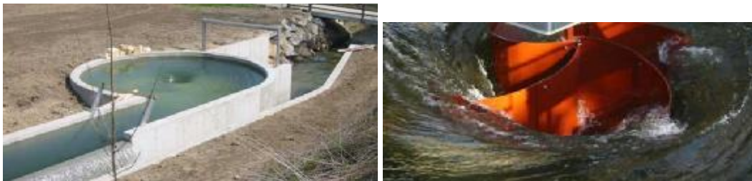
Obr. 4.14: Vlevo: vírová elektrárna , Vpravo: Zotlöterer turbína
