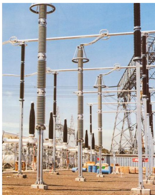
Obr.13.18 – Ukázka ventilové bleskojistky VVN (Siemens)
