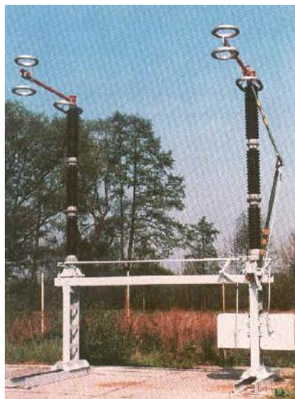
Obr. 3.2. – Vlastní provedení odpojovače – vvn
