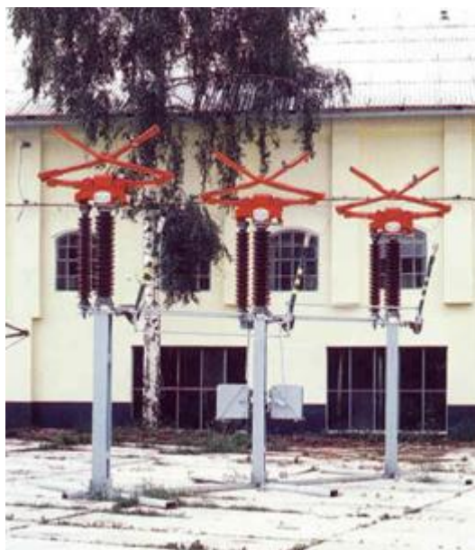
Obr. 3.4. – Příklad konstrukce posuvných (pantografových) odpojovačů
