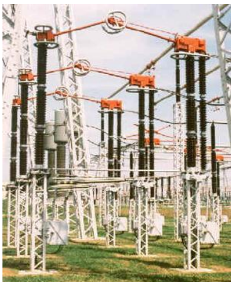
Obr. 3.2. – Vlastní provedení odpojovače – vvn
