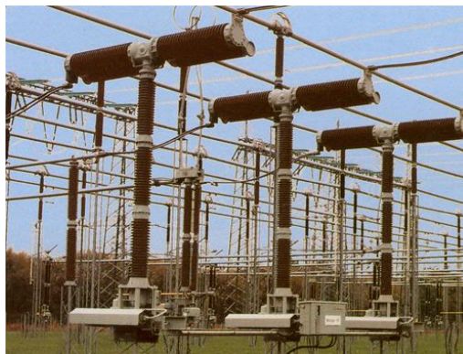
Obr. 10.4. – Vypínač \text{SF}_6 Siemens 3AT3 (300kV/4000A) s vypínacím odporem
